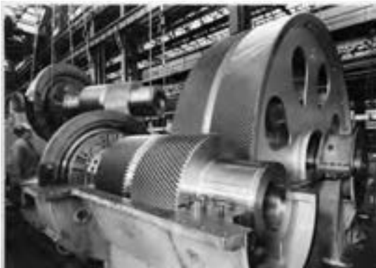
شکل ۲۶ - جعبه دنده یک شناور بزرگ
