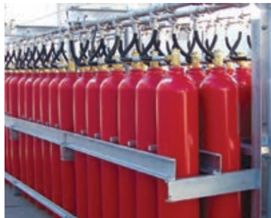
شکل ۳۸- سامانه اطفای حریق CO 2
