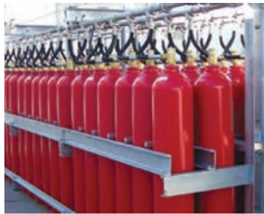
شکل ۳۸- سامانه اطفای حریق CO 2
