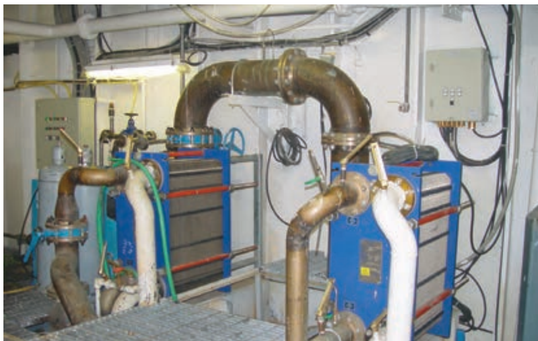
شکل ۶ - سامانه خنک کاری آب دریا
