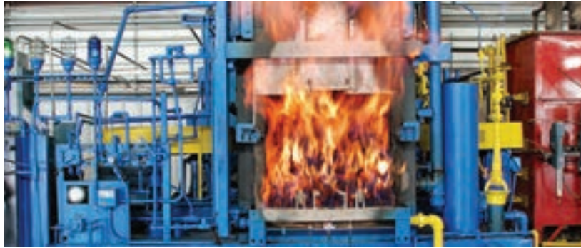
شکل ۸- کوره با اتمسفر کنترل شده
