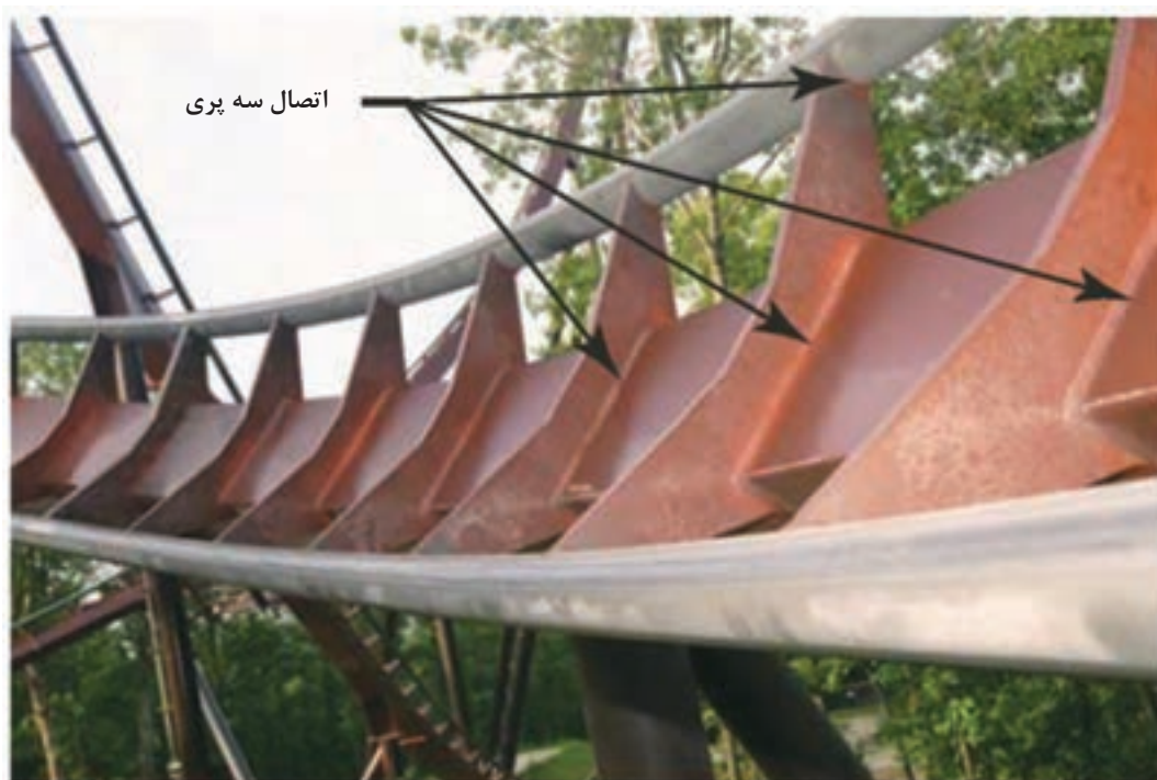
شکل ۱۲- کاربرد اتصال سه پری
