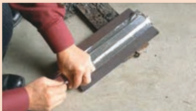
شکل ۱۸- نصب پشت بند سرامیکی
