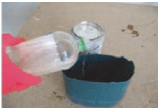
شکل ۸۴- استفاده از تینر فوری در روغن جلا
