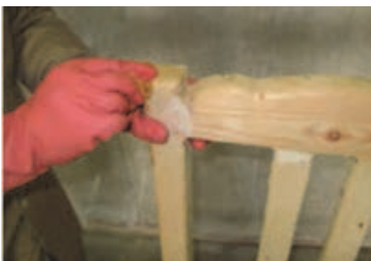
شکل ۷۱- بتونه کاری غیر پوششی
