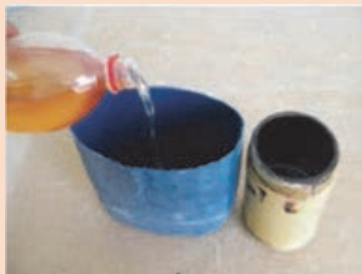
شکل ۷- رقیق کردن آستری قیری با بنزین
