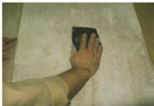
شکل ۸۰- سنباده کاری روی سطح بتونه سریشی
