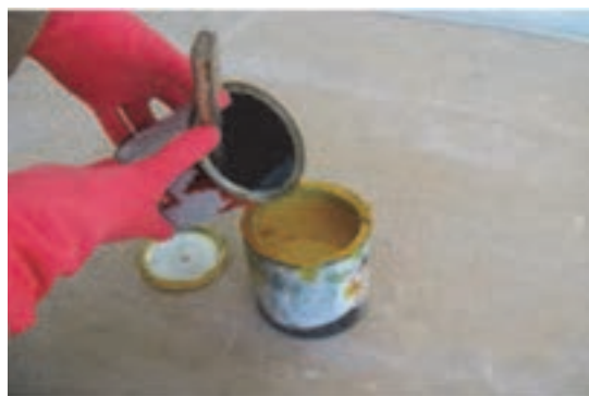
شکل ۸۵- اضافه کردن روغن جلا به رنگ روغنی
