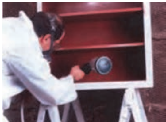
شکل ۲۳- رنگ کاری قسمت‌های داخلی
