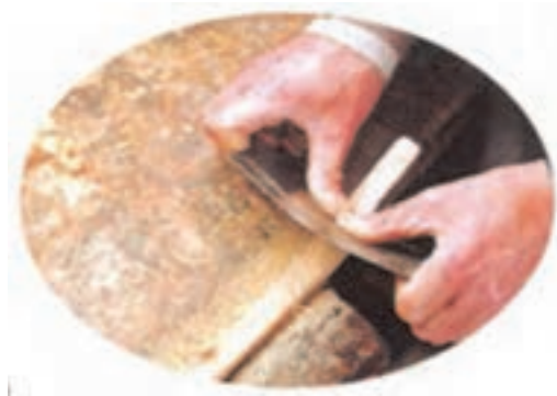
شکل ۵۶- استفاده صحیح از لیسسه
