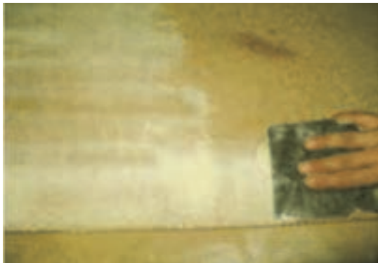
شکل ۷۳- استفاده از بتونه رقیق
