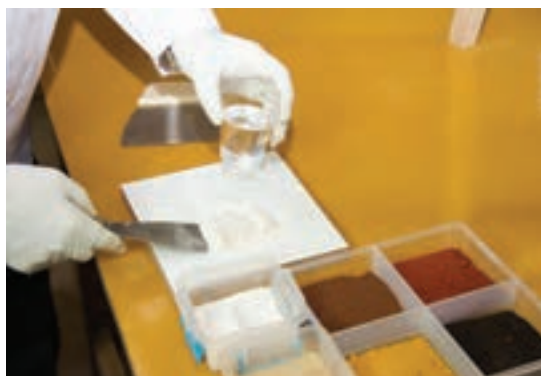
شکل ۷۰- اضافه کردن آب به بتونه
