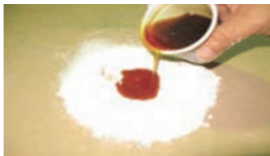
شکل ۸۶- اضافه نمودن رنگ روغنی به بتونه روغنی
