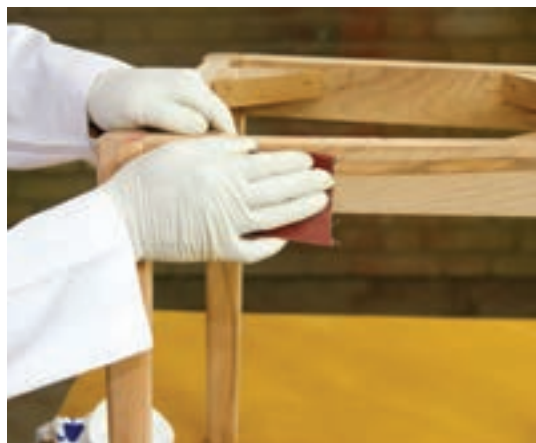
شکل ۱۲- سنباده کاری در جهت الیاف
