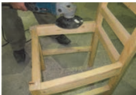
شکل ۷۲- پرداخت کاری قبل از بتونه
