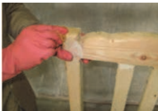
شکل ۷۱- بتونه کاری غیر پوششی
