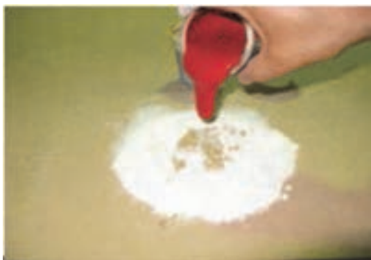
شکل ۷۹- اضافه نمودن روغن الیف به بتونه روغنی
