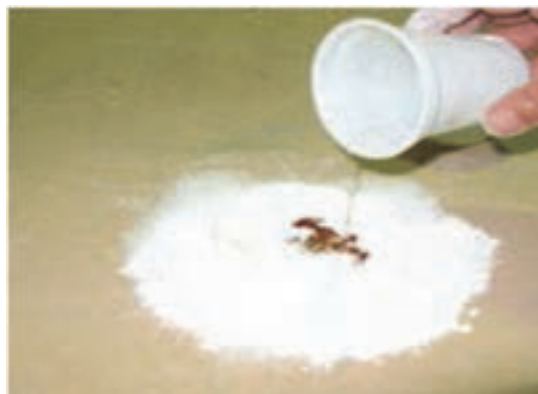
شکل ۷۸- اضافه نمودن آب به بتونه روغنی
