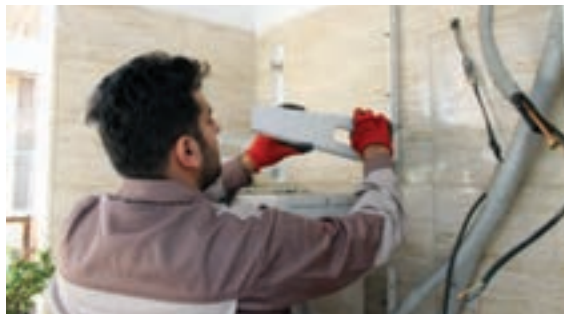
شکل ۷- نصب یونیت خارجی
