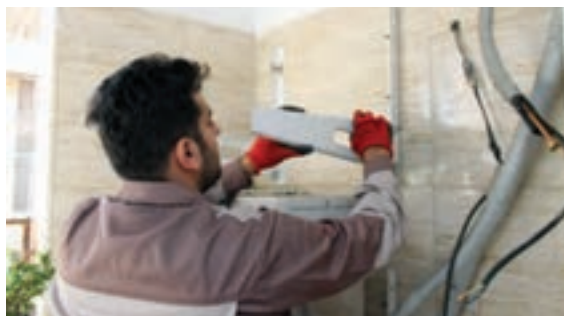
شکل ۷- نصب یونیت خارجی
