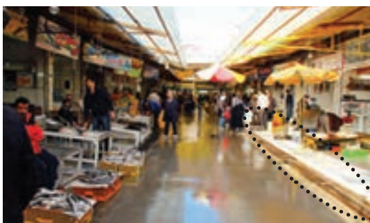
شکل ۲۵-۲- کف قابل شست‌وشو و مسیر جمع‌آوری آب‌بار در پوشش شبکه در وسط مسیر عبور در بازار ماهی‌فروش‌ها.
