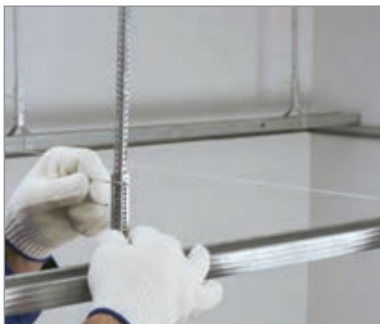
شکل ۴-۱۹- جزئیات و اتصالات شاسی سقف‌های کاذب
