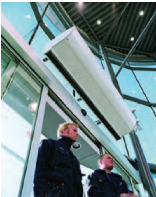
شکل ۲-۵۱- نصب دستگاه پرده هوا بالای در ورودی یک مرکز تجاری.
