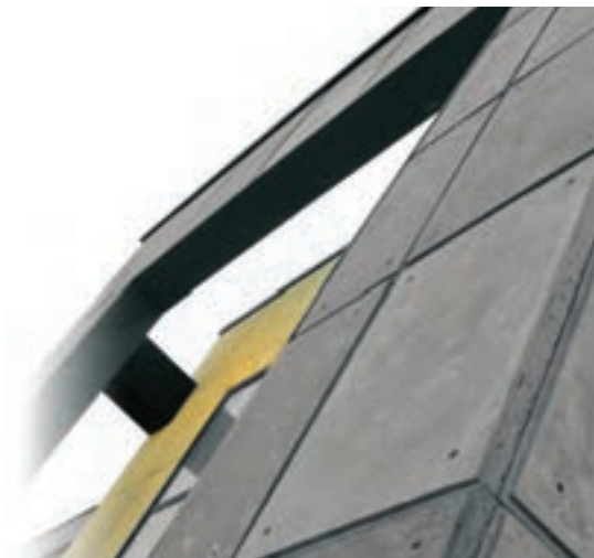
شکل ۴-۱۶ یک جداره بیرونی از بتن نمایان پانلی
