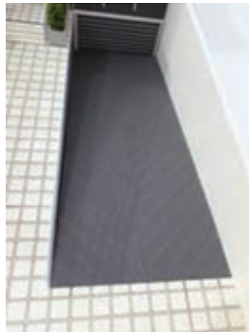
شکل ۱۱۰-۵- اجرای شیپارهای رامپ با کاتر و فشار دست
