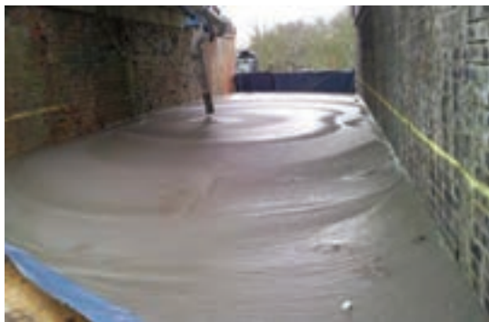
شکل‌های ۴-۵ و ۴-۶- شیبه‌های مختلف اجرای فوم بتن
