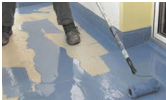
شکل ۴-۱۰- یکی از روش‌های اجرای اپوکسی
