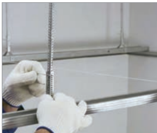
شکل ۴-۱۹- جزئیات و اتصالات شاسی سقف‌های کاذب
