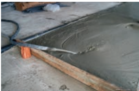
شکل ۴-۷- قالب‌بندی برای اجرای فوم بتن
