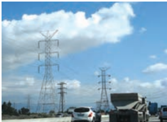
شکل ۵-۳- انتقال انرژی الکتریکی توسط دکل ها
