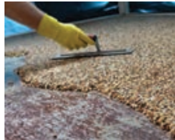
شکل ۳-۴۳- نمایش نحوه پخش و اجرای اپوکسی گرانیتی
