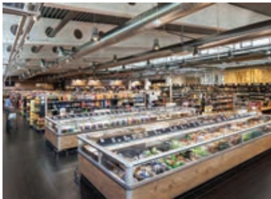
شکل ۲-۵۴- پیش‌بینی تأسیسات از زیر سقف به صورت نمایان و روباز، آسیب‌ها را عیان نموده و امکان تعمیر را ساده می‌سازد.
