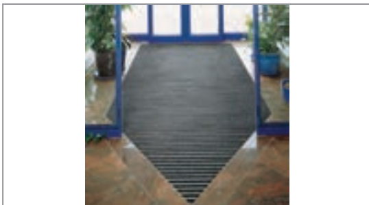
شکل ۲۷-۲- پیش‌بینی کفش پاک‌کن در ابتدای کف ورودی فروشگاه به تمیز ماندن داخل آن کمک بسیاری می‌کند.
