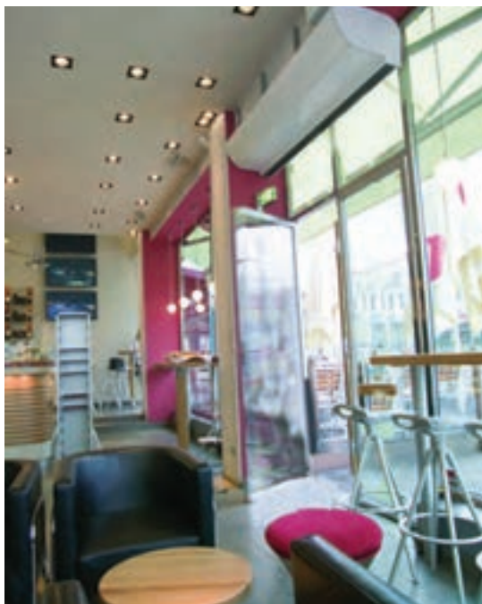
شکل ۲-۵۲- با باز شدن در، دستگاه بالای در ورودی به صورت خودکار فعال شده و با بسته شدن در، از کار می‌افتد.
