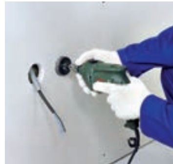
شکل ۱۷۳-۱- خروجی‌های تأسیساتی به وسیله گردبر ایجاد می‌شوند.
