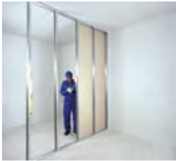
شکل ۱-۶۲- اجرای پانل‌ها در یک طرف دیوار
