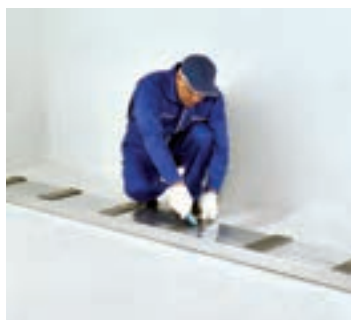
شکل ۸۲-۱- برش نوارهای عایق
