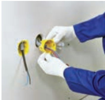
شکل ۱۷۵-۱- در حالی که گیره‌ها باز هستند، قوطی برق در محل خود قرار می‌گیرد.
