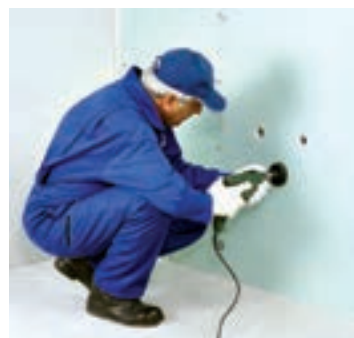
شکل ۱-۱۵۷- ایجاد خروجی‌های تأسیساتی به وسیله گردبر
