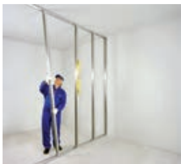
شکل ۸۳-۱- اجرای ردیف اول استاداها (به صورت شاقولی)
