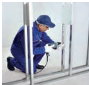
شکل ۱-۱۵۴- اتصال قطعات نبشی L۲۵ به استادهای مجاور
