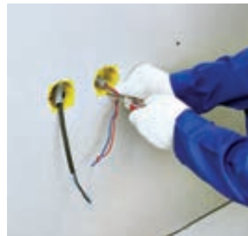
شکل ۱۷۶-۱- گیره‌ها توسط پیچ گوشتی جمع می‌شوند.
