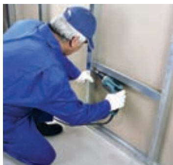
شکل ۱-۱۶۸- اتصال سازه پشتیبان به استادهای مجاور
