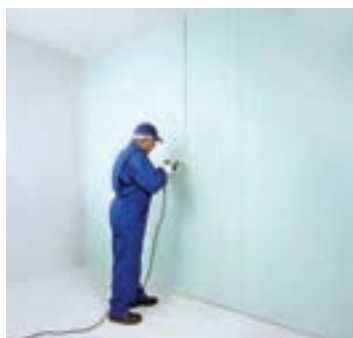
شکل ۱۰۱-۱- اجرای لایه دوم پانل‌ها
