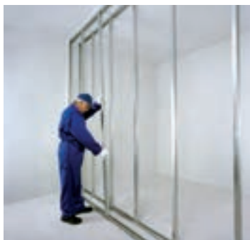
شکل ۱-۹۶- شاقولی کردن ردیف اول استادها
