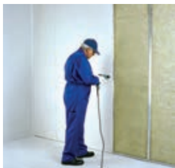
شکل ۸۸-۱- اجرای پانل‌ها در هر طرف دیوار
