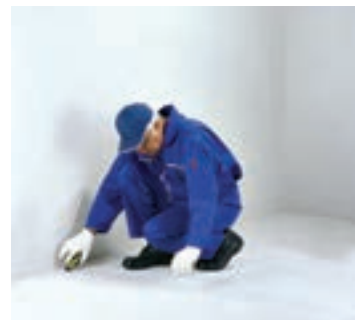
شکل ۳۹-۱- مشخص کردن محل نصب رانر کف با ریسمان رنگی
