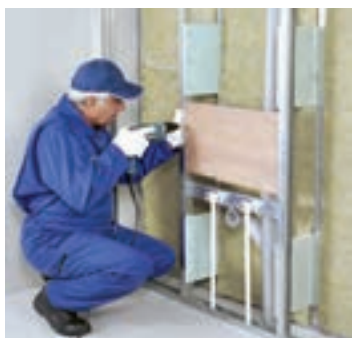
شکل ۱-۱۵۵- اتصال تراورس (تخته چند لایه) به قطعات نبشی L۲۵
