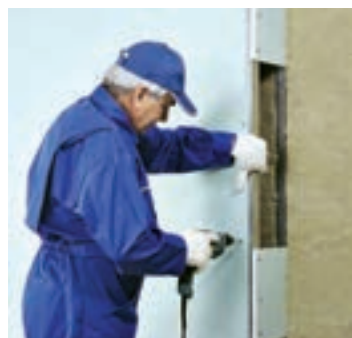
شکل ۱۰۰-۱- اجرای پانل‌ها در طرف دیگر دیوار
