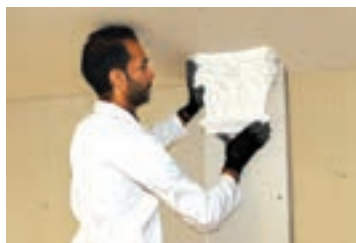
شکل ۲۴۲-۱- اتصال قطعه اول به ستون
