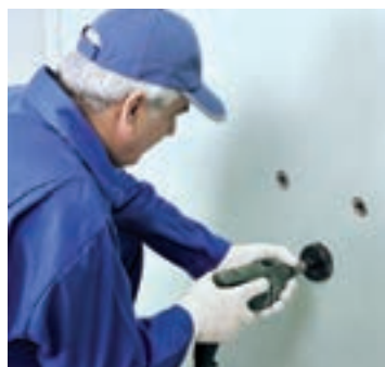
شکل ۱۰۲-۱- ایجاد خروجی تأسیسات به وسیله گرد بر
