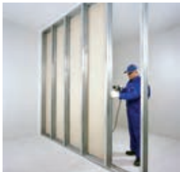
شکل ۸۶-۱- اجرای پانل‌ها در یک طرف دیوار
