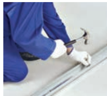
شکل ۴۲-۱- اتصال رانر به کف با رول پلاک
