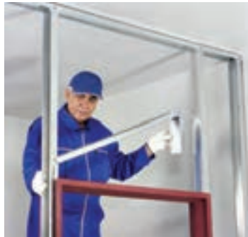
شکل ۱۲۹-۱- استقرار رانر نعل درگاه
