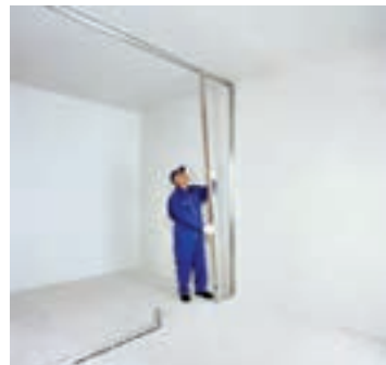
شکل ۱-۱۱۶- نصب استاد اول
