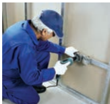
شکل ۱-۱۶۹- اتصال قوطی برق به سازه پشتیبان
