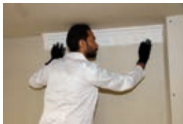
شکل ۲۴۵-۱- نصب قطعه پلی یورتان با چسب
