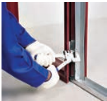
شکل ۱-۱۲۱- اتصال پایین استاد با پانچ
