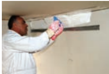
شکل ۲۳۸-۱- کشیدن ابزار
