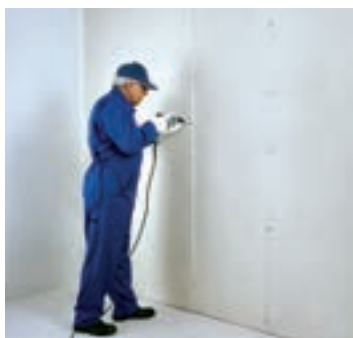
شکل ۸۹-۱- اجرای لایه دوم پانل‌ها
