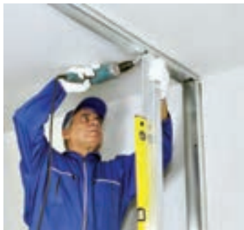
شکل ۱-۱۱۸- اتصال بالای استاد با پیچ LB
