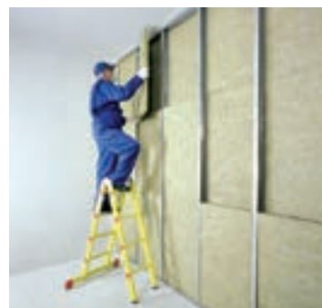
شکل ۸۷-۱- اجرای عایق پشم معدنی
