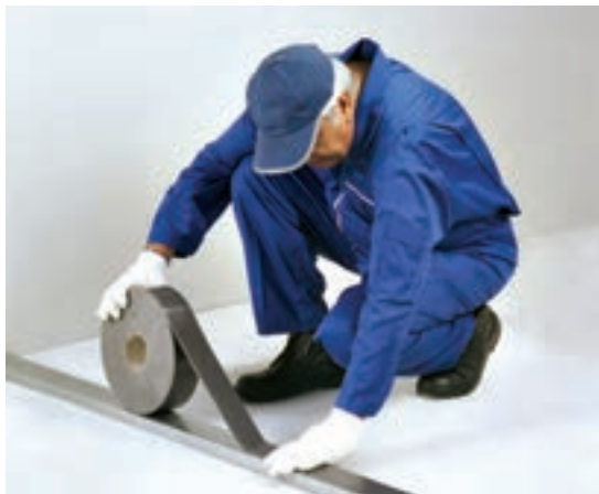
شکل ۳۶-۱- نوار فوم عایق
