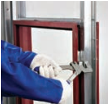
شکل ۱۳۰-۱- اتصال رانر نعل درگاه به استادهای با پانچ
