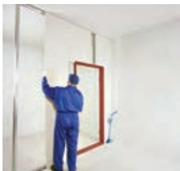
شکل ۱-۱۳۹- اجرای پانل دوم دور چهارچوب
