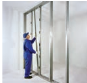
شکل ۸۴-۱- اجرای ردیف دوم استاداها
