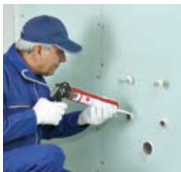
شکل ۱-۱۵۹- اجرای خمیر درزبند در اطراف خروجی‌های تأسیساتی
