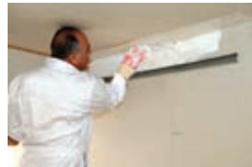
شکل ۲۳۷-۱- اجرای اندود گچ
