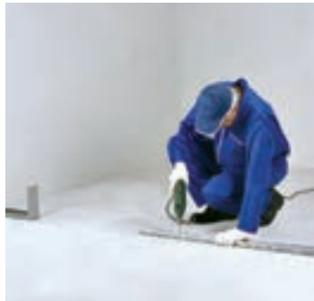
شکل ۱-۱۱۴- نصب رانر کف
