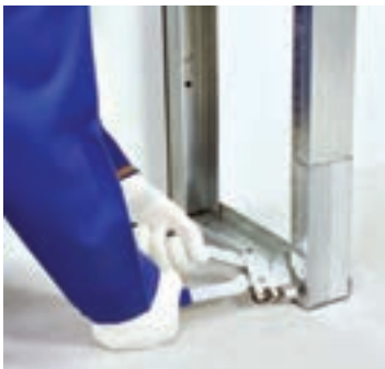
شکل ۱-۱۱۷- اتصال پایین استاد با پانچ
