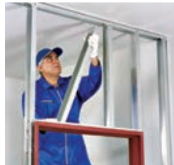
شکل ۱۳۱-۱- استقرار استادهای کتیبه
