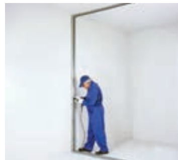
شکل ۱-۵۲ - نصب استاد بر روی ساختار جانبی
