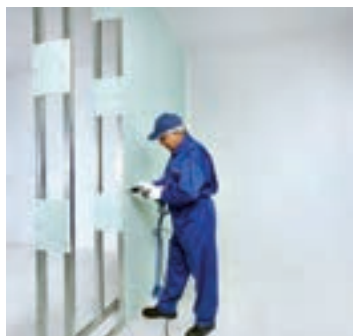
شکل ۹۸-۱- اجرای پانل‌ها در یک طرف دیوار
