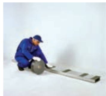
شکل ۸۱-۱- اجرای نوار عایق بر روی استاداها
