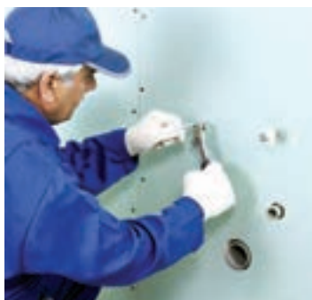
شکل ۱-۱۵۸- اتصال مهار روشویی به تراورس
