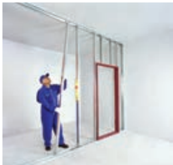
شکل ۱-۱۳۶- اجرای استادهای دیوار
