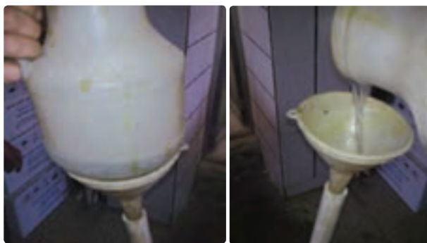
شکل ۱۸- شست و شوی مبدل بعد از رسوب‌زدایی
