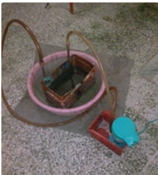
شکل ۱۹- رسوب‌زدایی با پمپ
