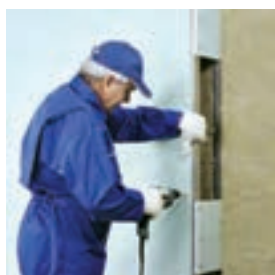
اجرای پانل‌ها در طرف دیگر دیوار
