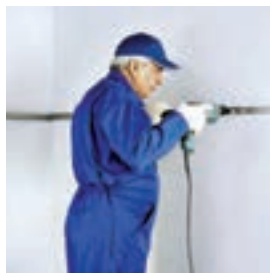
نصب سازه تراز باربر (فاصله پیچ‌ها بر روی دیوار سنتی ۳۰ و بروی دیوار درای وال هر ۶۰ سانتی‌متر می‌باشد)
