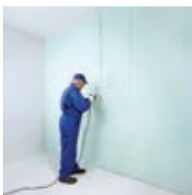
اجرای لایه دوم پانل‌ها
