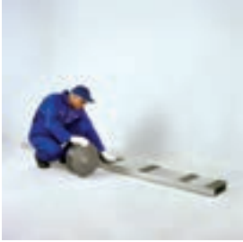
اجرای نوار عایق بر روی استاداها
