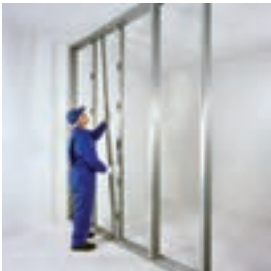
اجرای ردیف دوم استاداها
