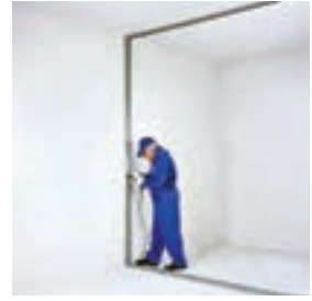
نصب استاد بر روی ساختار جانبی
