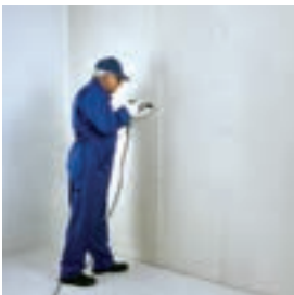
اجرای لایه دوم پانل‌ها
