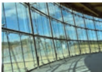
نمای شیشه‌ای با سیستم اسپایدر (سیستم عنکبوتی)
