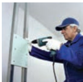
استادهای ردیف اول و دوم به وسیله برش‌هایی از پانل به یکدیگر وصل می‌شوند
