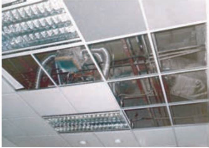
تصویر ۲۰ - زیر سازی سقف کاذب
