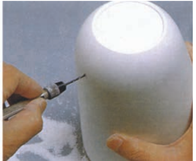
۲۰- ایجاد سوراخ و پین گذاری برای اتصال قطعه الحاقی (مرحله چهارم - مونتاژ)
