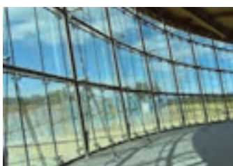
نمای شیشه‌ای با سیستم اسپایدر (سیستم عنکبوتی)
