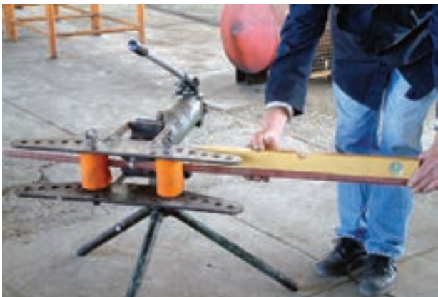
شکل ۳-۴۳- کنترل افقی بودن لوله در خم کاری
