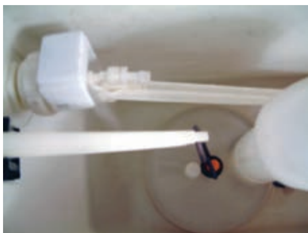
شکل ۲۲۴-۳- بر شدن مخزن فشاری
