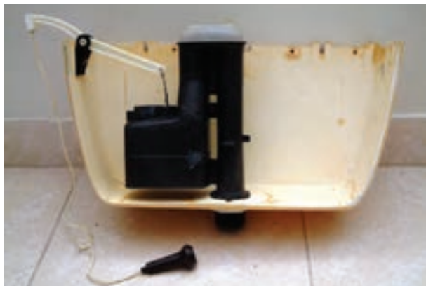
شکل ۳-۲۰۷- نصب پمپ تخلیه درون مخزن فشار
