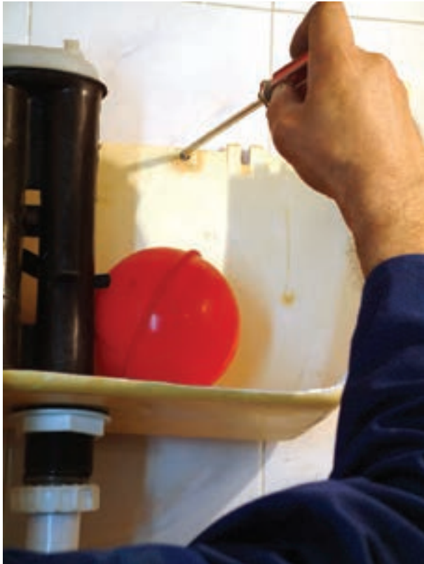
شکل ۲۱۳-۳- نصب مخزن فشاری به دیوار
