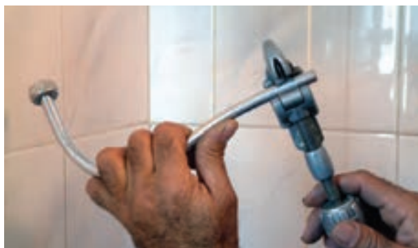
شکل ۲۲۲-۳- بریدن لوله‌ی پیسوار به وسیله‌ی لوله‌بر
