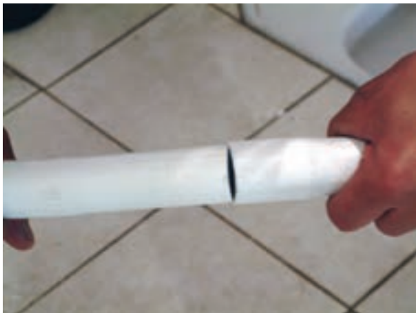
شکل ۳-۲۰۶- جا زدن لوله‌های تخلیه در درون یکدیگر
