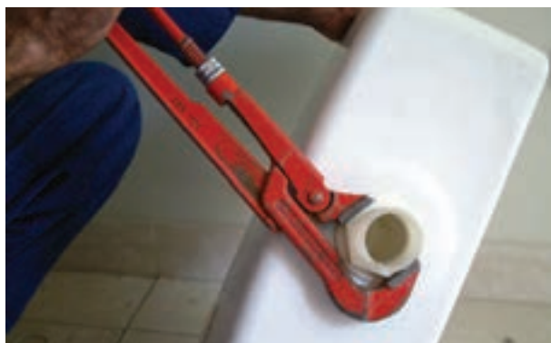
شکل ۳-۲۰۸- سفت کردن مهره‌ی پمپ تخلیه
