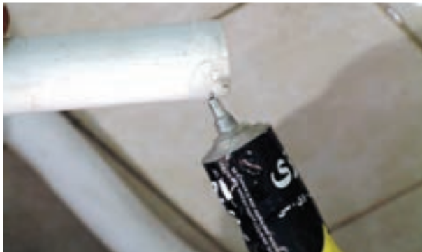
شکل ۳-۲۰۵- زدن چسب به لوله‌های تخلیه
