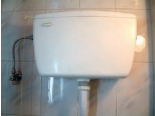
نصب مخزن فشاری
