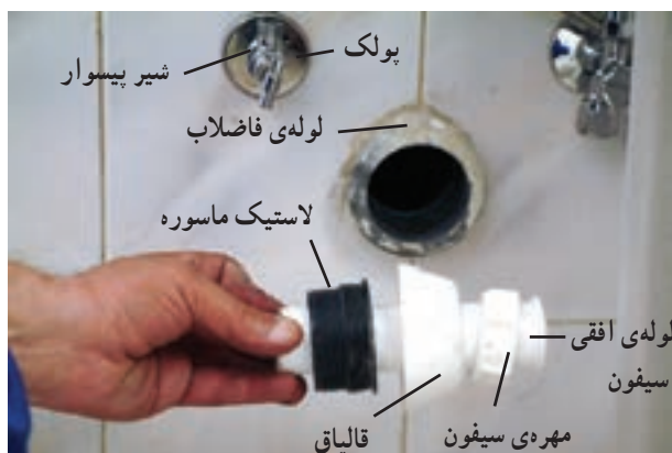
شکل ۳-۵۲ قرار دادن لوله افقی سیفون در درون مهره سیفون کاسه و لاستیک ماسوره
