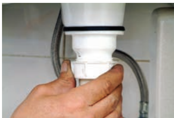
شکل ۳-۵۶ بستن مهره‌ی لوله‌ی عمودی سیفون به زیراب
