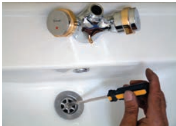
شکل ۳-۴۰ نصب زیراب بر روی دستشویی
