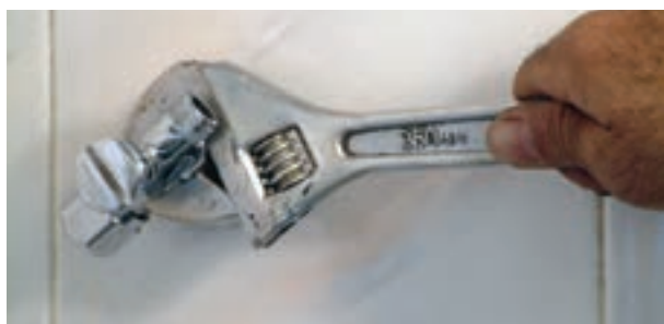
شکل ۳-۴۸ سفت کردن شیر پیسوار با آچار فرانسه
