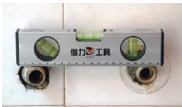
شکل ۲-۲۰۳- کنترل تراز بودن دنباله‌ها
