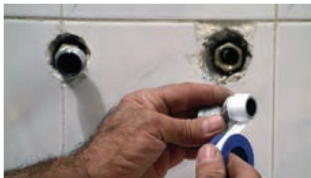
شکل ۲-۱۸۳- بیچیدن نوار تفلون به دنباله‌ها
