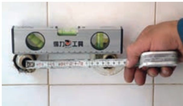
شکل ۲-۱۸۶- کنترل صاف بودن و اندازه‌ی دنباله‌ها
