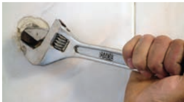
شکل ۲-۱۸۲- بازکردن درپوش‌ها
