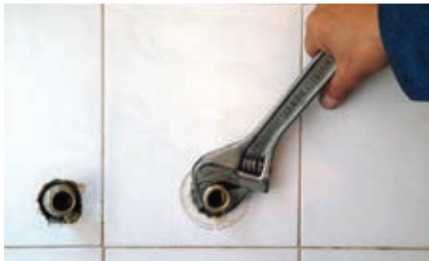
شکل ۲-۲۰۱- سفت کردن دنباله‌ها با آچار
