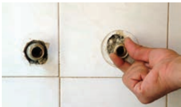
شکل ۲۰۰-۲- بستن دنباله‌ها با دست
