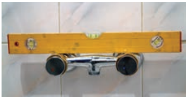
شکل ۱۹۰-۲- سنجش تراز بودن شیر مخلوط
