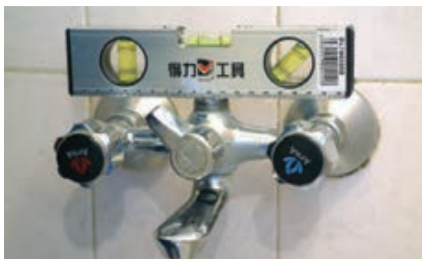
شکل ۲-۲۰۷- سنجش تراز بودن شیر مخلوط دوش
