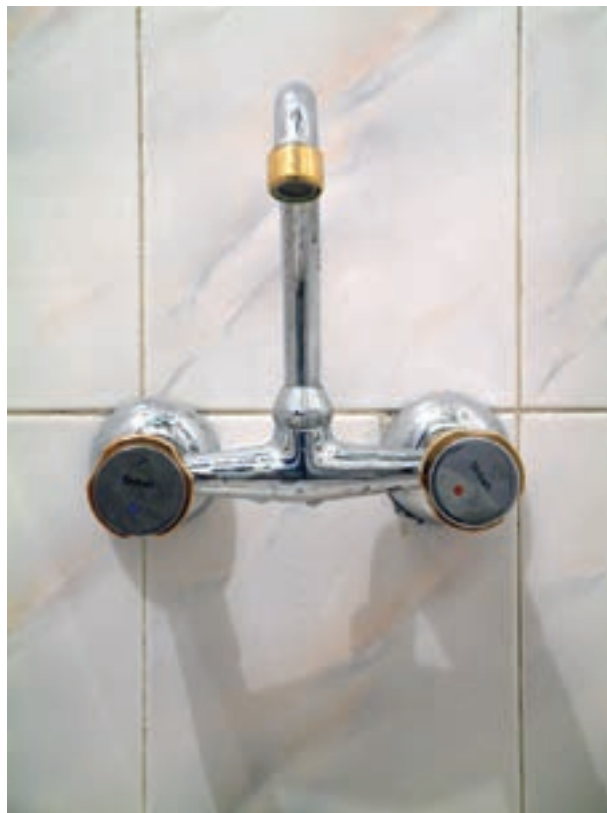
نصب شیر مخلوط دیواری
