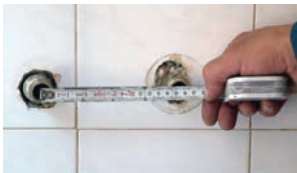
شکل ۲-۲۰۲- کنترل نمودن فاصله‌ی دنباله‌ها به وسیله‌ی متر
