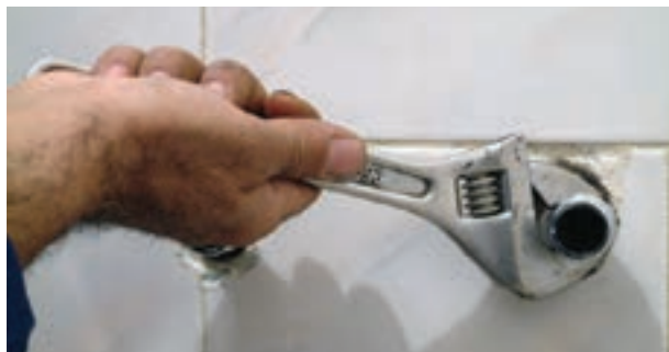
شکل ۱۶۷-۲ سفت کردن دنباله‌ها با آچار فرانسه
