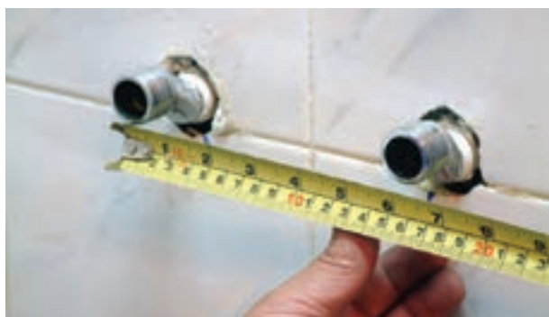
شکل ۱۶۸-۲ کنترل اندازه‌ی محور تا محور دنباله‌ها
