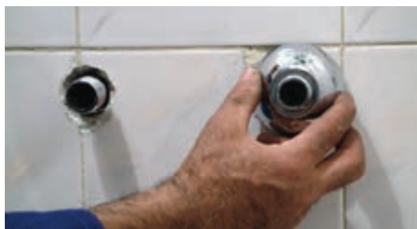
شکل ۲-۲۰۴- پیچیدن کاسه‌ها به دنباله‌ها
