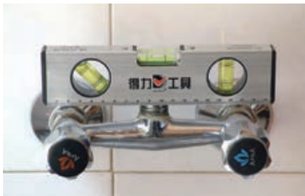
شکل ۱۷۴-۲- سنجش تراز بودن شیرمخلوط دیواری
