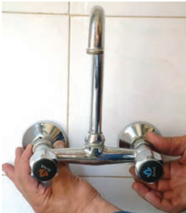
شکل ۱۷۲-۲- پیچیدن مهره‌ها به دنباله‌های شیر مخلوط
