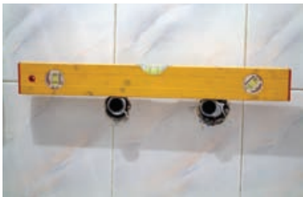
شکل ۲-۱۶۹- کنترل صاف بودن دنباله‌ها
