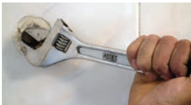
شکل ۱۹۸-۲- باز کردن درپوش‌ها
