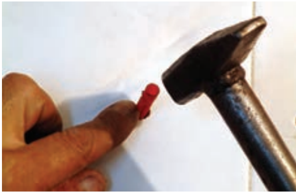
شکل ۱۹۳-۲- کوبیدن رولپلاک درون سوراخ
