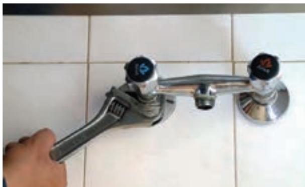
شکل ۱۸۹-۲- سفت کردن مهره‌ها با آچار فرانسه
