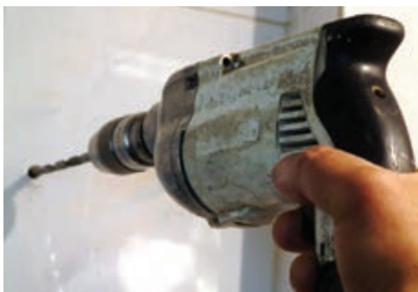
شکل ۱۹۲-۲- سوراخ کردن محل نصب بست آویز
