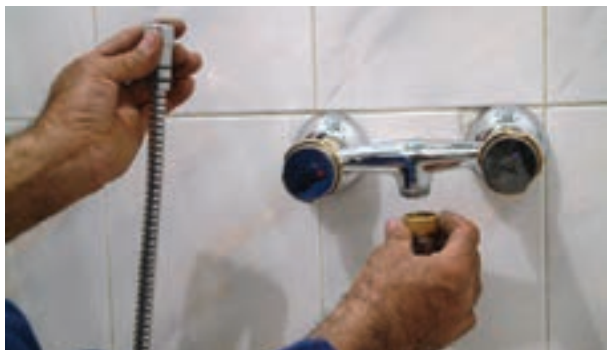
شکل ۱۹۱-۲- اتصال شیلنگ آفتابه به شیر مخلوط توالت
