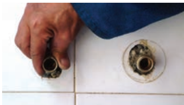
شکل ۲-۱۸۴- بیچیدن دنباله‌ها به محل نصب شیر
