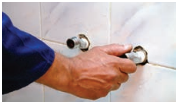
شکل ۱۶۶-۲ پیچیدن دنباله‌های شیر مخلوط دیواری با دست به لوله‌های آب سرد و آب گرم
