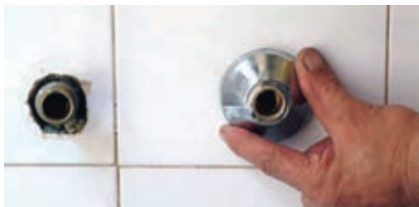
شکل ۲-۱۸۷- اتصال کاسه‌ها به دنباله‌ها
