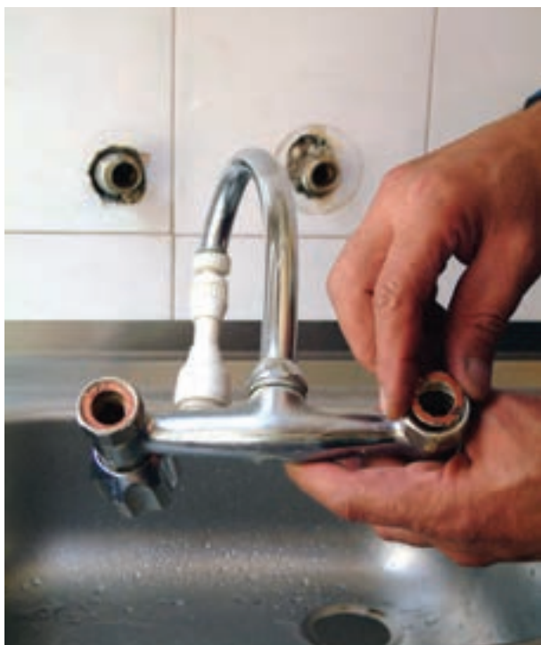
شکل ۲-۱۷۱- قراردادن واشر درون مهره‌ی تنه شیرمخلوط
