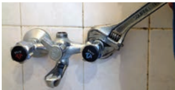
شکل ۲-۲۰۶- سفت کردن مهره‌های شیر با آچار
