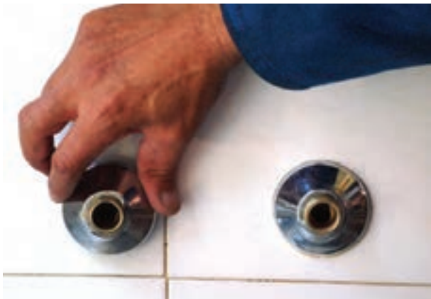
شکل ۲-۱۷۰- بستن کاسه‌ها به دنباله‌ها با دست
