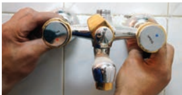
شکل ۲-۲۰۵- بستن مهره‌های شیر مخلوط دوش با دست
