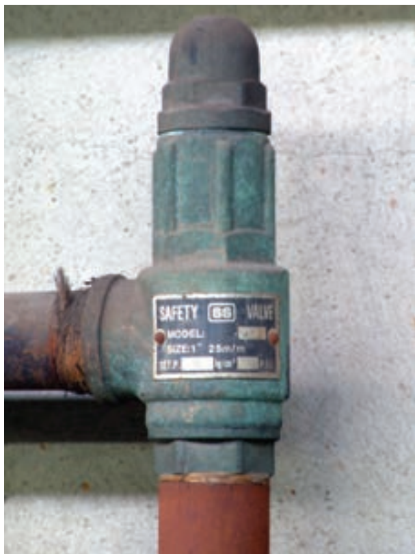
شکل ۱۰۶-۲ شیر اطمینان حساس در برابر فشار
