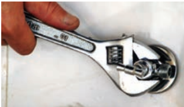
شکل ۱۴۴-۲- سفت کردن شیر پیسوار با آچار فرانسه
