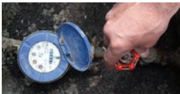
شکل ۱۴۰-۲- بستن شیر فلکه‌ی اصلی
