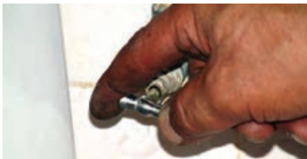
شکل ۱۴۶-۲- عمل هواگیری
