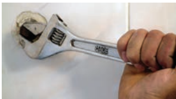
شکل ۱۴۱-۲- باز کردن درپوش
