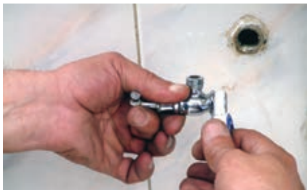
شکل ۱۴۲-۲- پیچیدن نوار تفلون به دنده‌ی \frac{۳}{۴} شیر پیسوار
