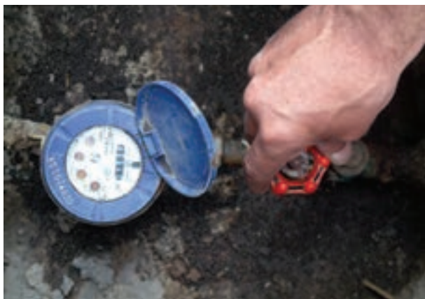
شکل ۲-۶۰ بستن شیر فلکه‌ی اصلی آب ساختمان
