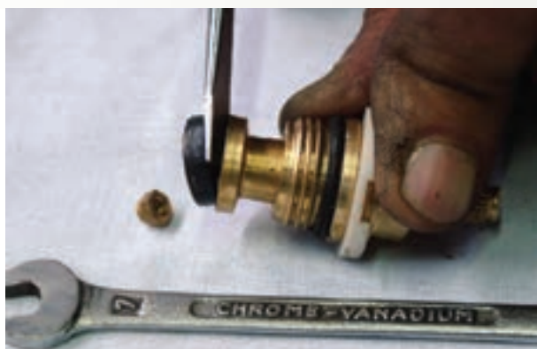
شکل ۲-۶۳- تعویض واشر
