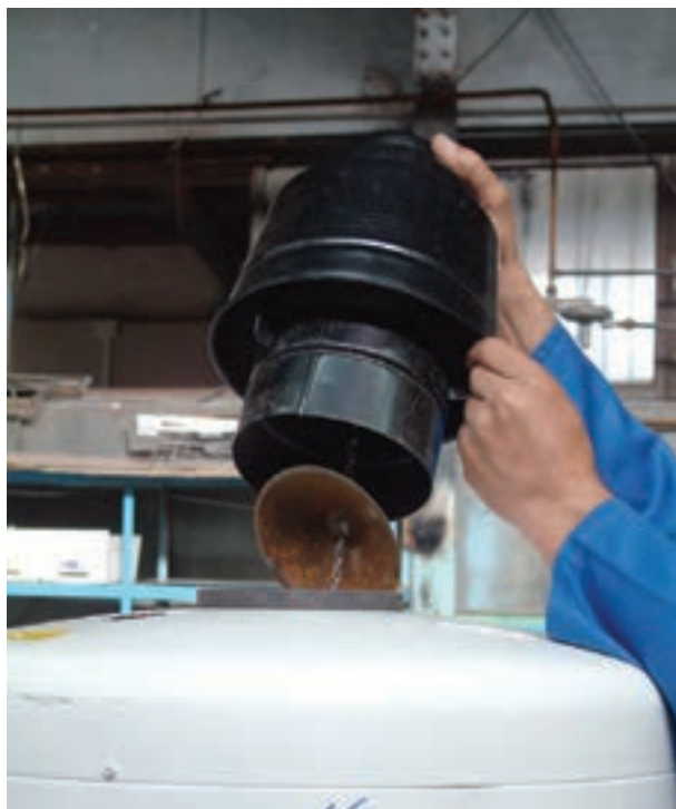
شکل ۱-۱۱۵- برداشتن کلاهک تعدیل از روی دودکش
