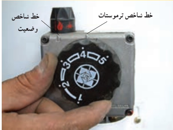
شکل ۱-۱۱۰- تغییر کلید تنظیم دما (ترموستات)
