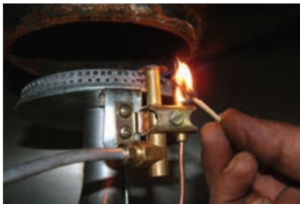
شکل ۱-۱۰۵ مشتعل کردن شمعی به وسیله‌ی شعله‌ی کبریت
