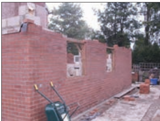
شکل ۱-۱۰۷ دیوار باربر آجری
