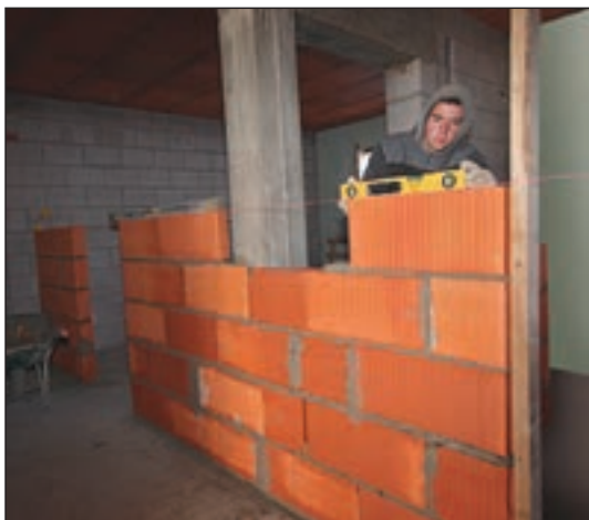
شکل ۱-۱۰۹ دیوار غیرباربر بلوک سفالی
