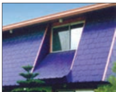
شکل ۴۷-۱ پوشش نهایی سقف شیب‌دار با آردواز
