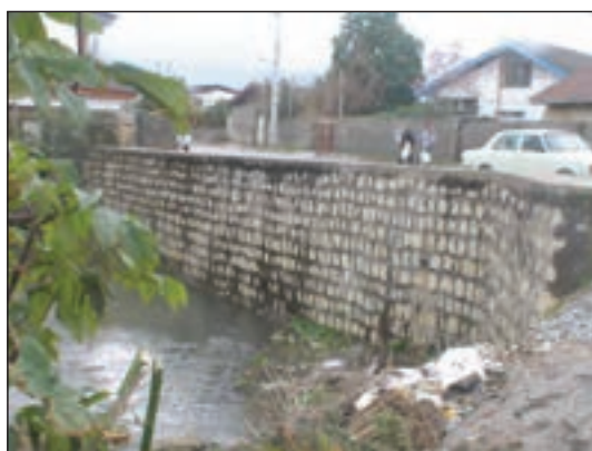
شکل ۱-۱۱۰ دیوار حائل سنگی
