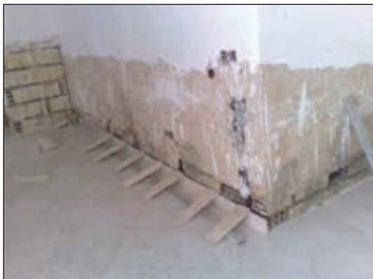
شکل ۱-۹۰ اندود گچ و خاک - گچ سفید پرداختی
