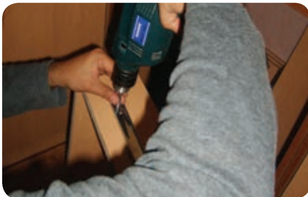
شکل ۱۷۶-۵- نصب ریل تکی به بدنه کشو
