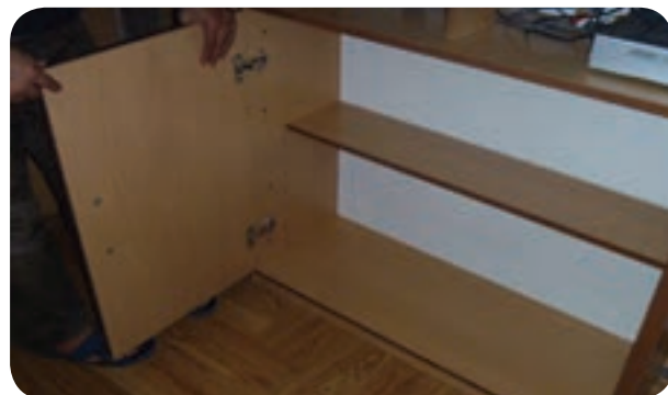
شکل ۵-۱۶۴- نصب در کمد زیر جای تلویزیون
