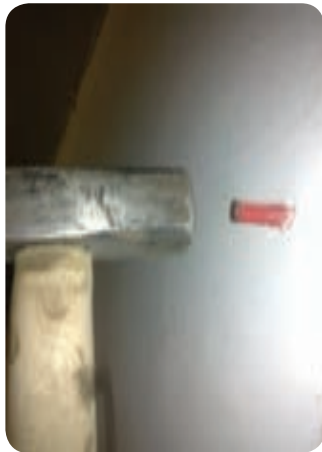
شکل ۶-۸ - جاسازی رولپلاک در داخل سوراخ دیوار به وسیله چکش
