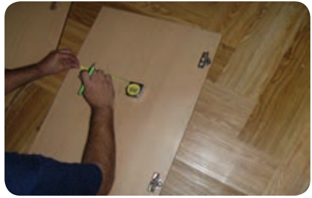
شکل ۱۵۰-۵- نصب لولای در کمد
