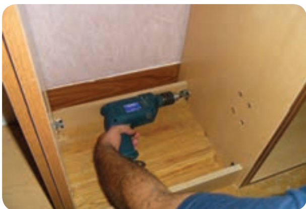
شکل ۱۸۰-۵- نصب پاسنگ‌ها
