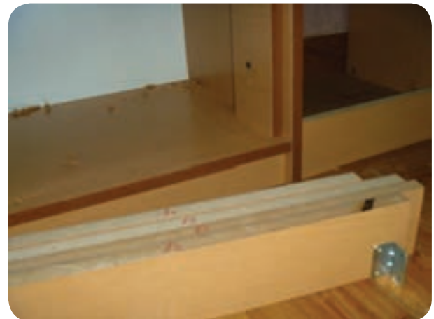
شکل ۱۶۶-۵- نصب پاسبنگ با استفاده از گونیای فلزی
