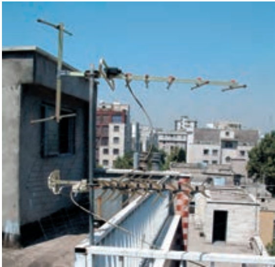
شکل ۱-۶۹- آنتن VHF و UHF روی دکل
