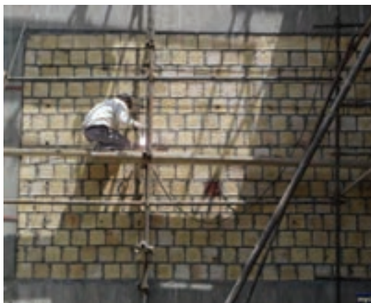
شکل ۴-۳- اجرای دیوار خارجی با بلوک سفالی
