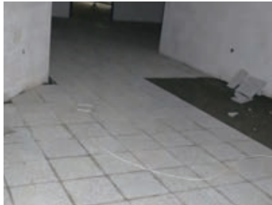
شکل ۲۷-۴- اجرای کف موزائیک در داخل ساختمان
