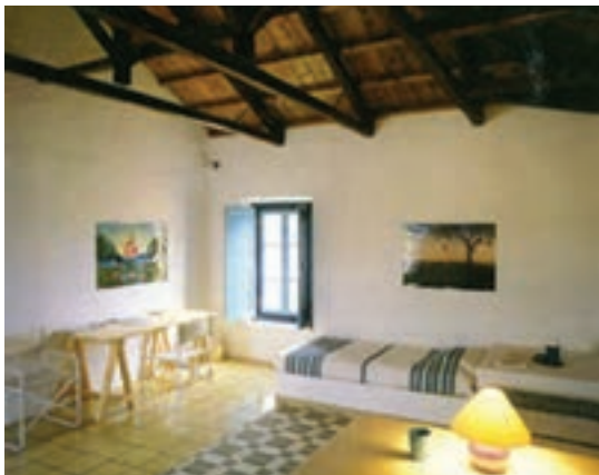
شکل ۹۹-۲- سازه آشکار در اتاق خواب
