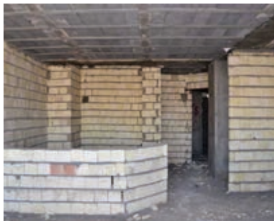
شکل ۴-۴- تیغه چینی داخلی با بلوک سفالی
