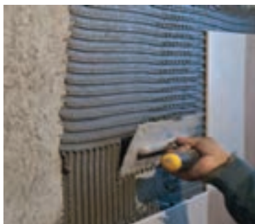
شکل ۳۱-۴- نقشه یک دیوار نمونه از فضای آبریزگاهی شکل ۳۲-۴- اجرای سرامیک کف با چسب سرامیک شکل ۳۳-۴- اجرای کاشی دیوار با چسب کاشی
