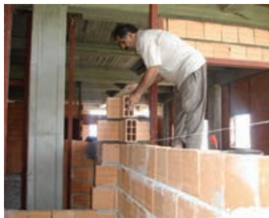
شکل ۱-۴- ریسمان کشی جهت اجرای مستقیم دیوار
