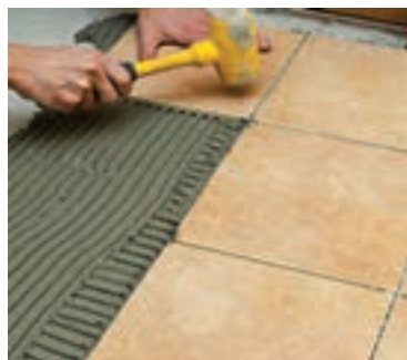
شکل ۳۱-۴- نقشه یک دیوار نمونه از فضای آبریزگاهی شکل ۳۲-۴- اجرای سرامیک کف با چسب سرامیک شکل ۳۳-۴- اجرای کاشی دیوار با چسب کاشی
