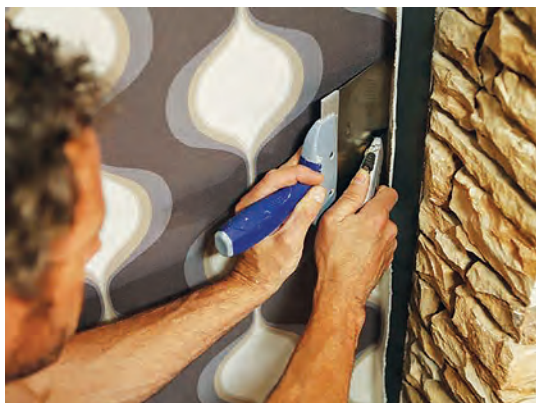
شکل ۸۵- برش اضافه پارچه روی دیوار
