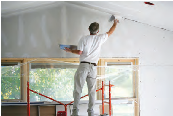
شکل ۱۸- پرداخت درز بین دیوار و سقف کاذب
