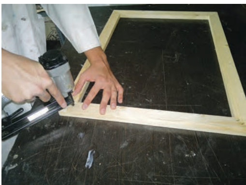
شکل ۲۸-منگنه زدن پشت قاب
