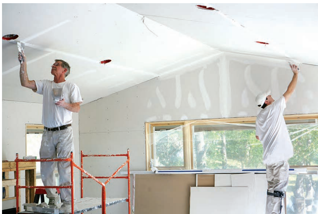
شکل ۱۴- استفاده از زیرپایی ایمن برای کار در ارتفاع
