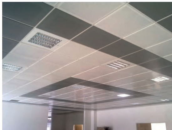
شکل ۱- اجرای سقف کاذب با مواد صداگیر
