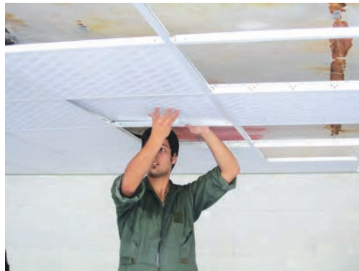
شکل ۱۷- نصب و تنظیم پنل در شبکه فلزی
