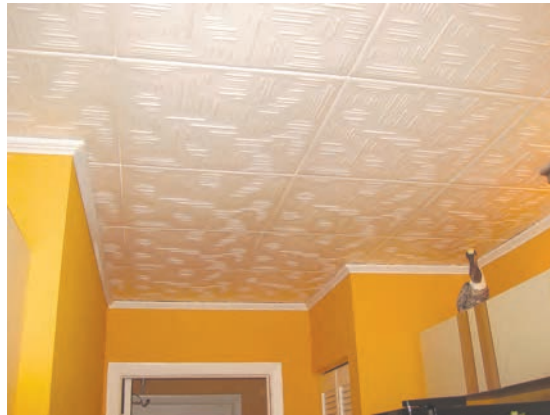
شکل ۳- اجرای سقف کاذب با فوم
