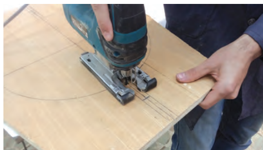
شکل ۵۹- شروع برش کفی دایره شکل از محل شکاف پایه‌ها
