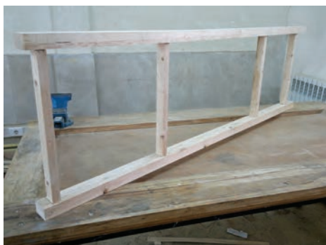
شکل ۵۲- اتصال موقت قطعات پاراوان
