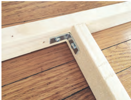
شکل ۲۱- اتصال با بست گونیايي
