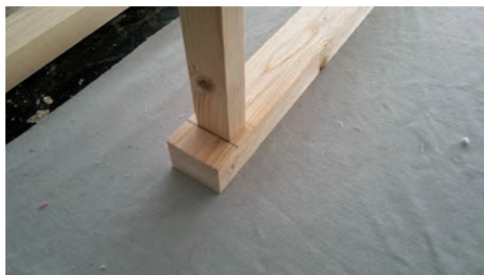
شکل ۴۷- استقرار قید افقی بر روی قید طولی
