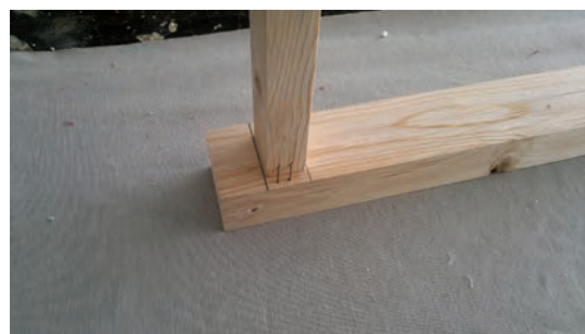
شکل ۴۹- زدن دو منگنه روی قید اول
