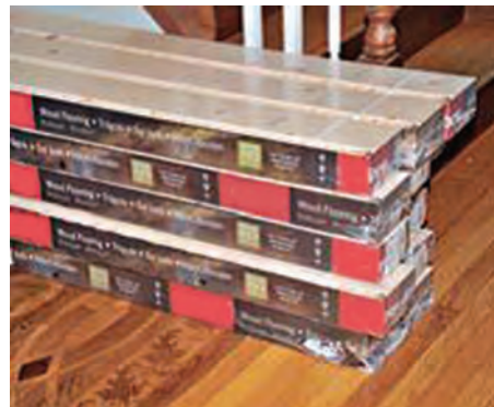
شکل ۲۸ و ۲۹- نحوه قرار دادن درست جعبه‌های لمینت
