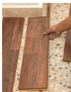
شکل ۹۰ و ۹۱ - قفل کردن قطعات لمینت به یکدیگر
