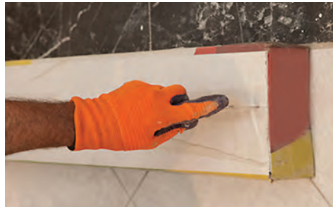
شکل ۲۸ و ۲۹- نحوه قرار دادن درست جعبه‌های لمینت
