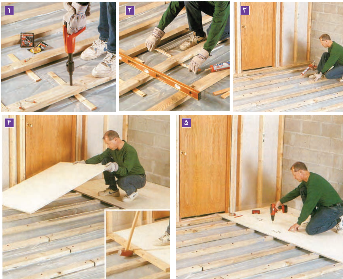
شکل ۴- مراحل نصب کف با تخته چوبی
