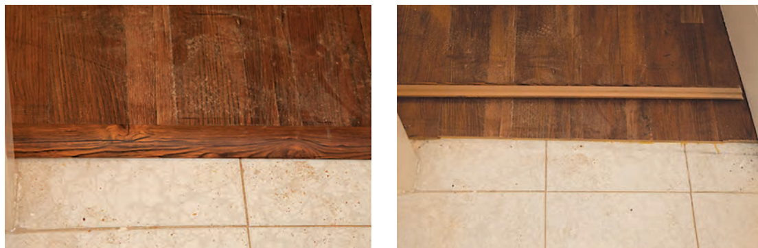
شکل ۸۲ و ۸۳ - پشت و روی پروفیل آستانه
