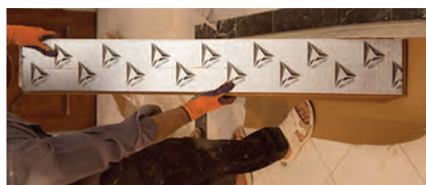
شکل ۲۸ تا ۳۱- مراحل باز کردن جعبه‌های لمینت
