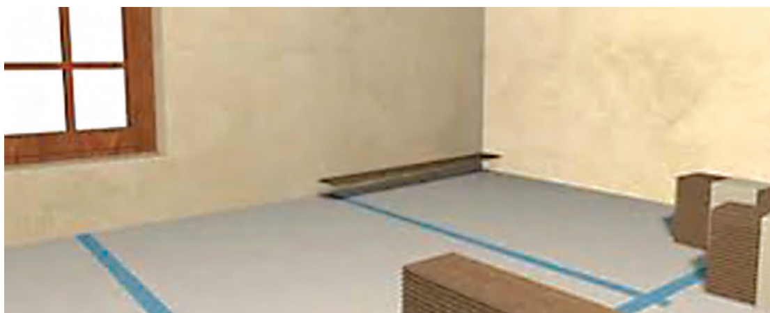
شکل ۲۴ - پوشش کامل کف با فوم صدا گیر
