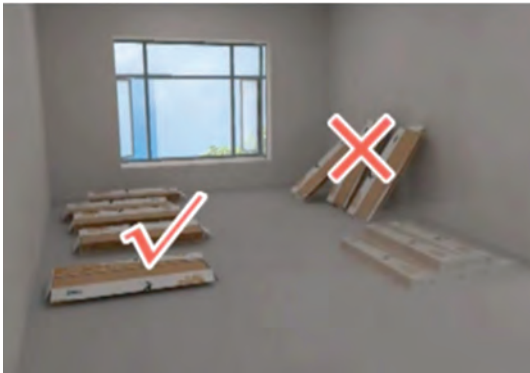
شکل ۲۸ و ۲۹- نحوه قرار دادن درست جعبه‌های لمینت
