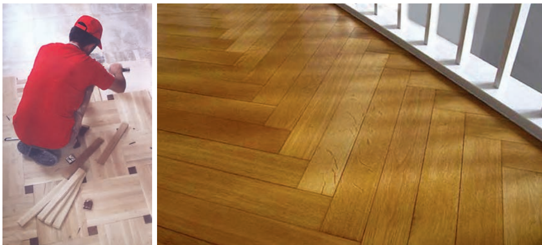
شکل ۷ و ۸- نمونه‌هایی از کف‌سازی با بلوک‌های چوبی
