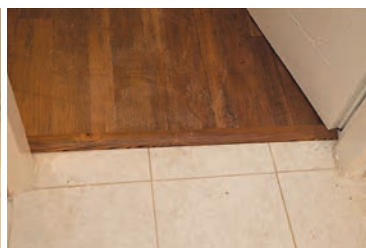
شکل ۹۲ تا ۹۴ - نصب لمینت در آستانه در
