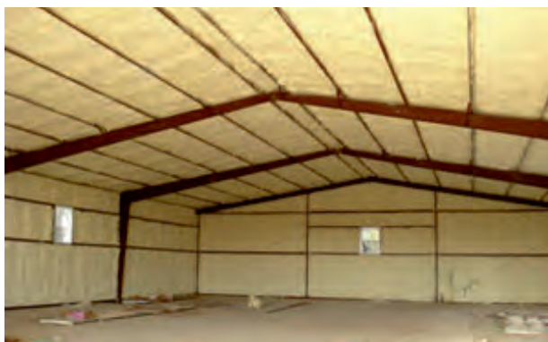
عایق‌بندی سقف و دیواره
