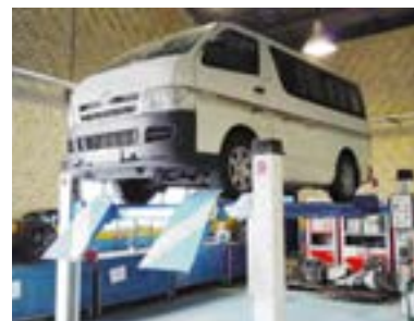
۱- خودرو روی جک بالا بردار ارتفاع مناسبی قرار گیرد.
