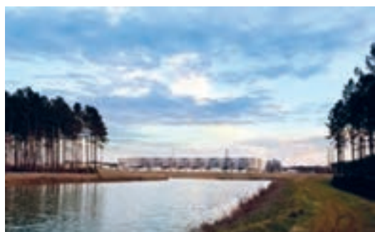
شکل ۸- Data center های گوگل روی یخ‌های قطبی فنلاند
