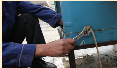
نصب لوله به شیر شناور
