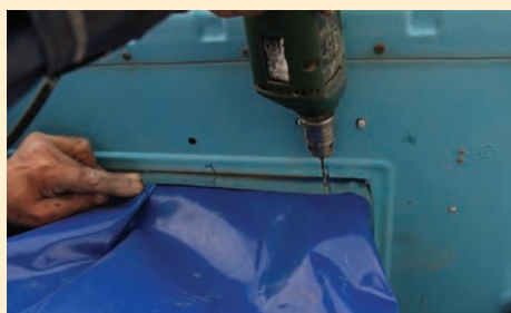
اتصال کانال توزیع هوا به دهانه کولر
