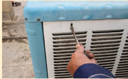
تنظیم آب پخش کن
