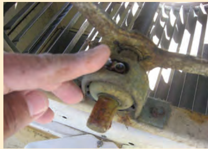
محل روغن کاری یاتاقان
