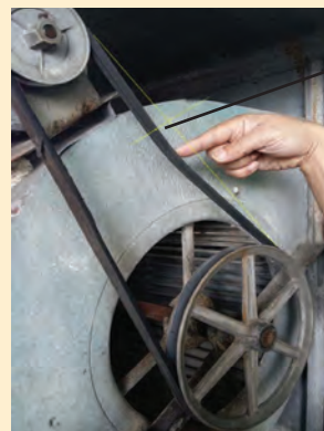
آزمایش سفتی تسمه
