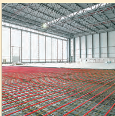
کارخانه‌ها و سوله‌های صنعتی
