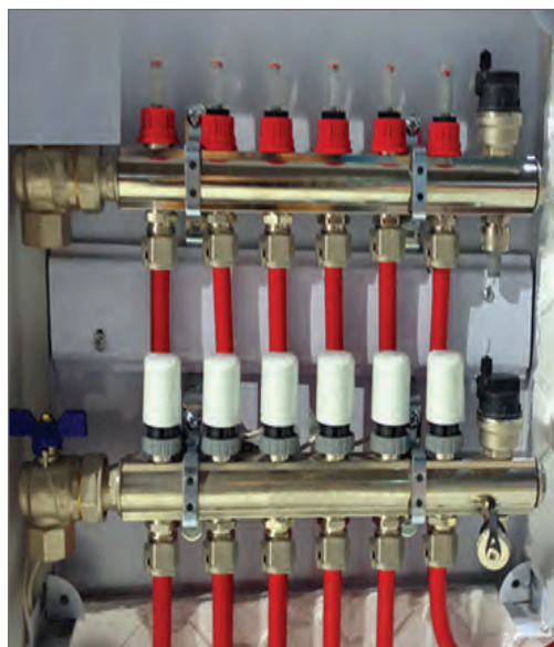
کلکتور سیستم کف گرمایی
