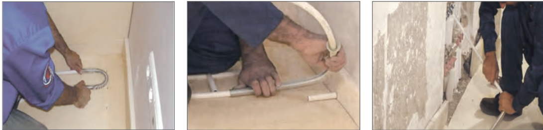
استفاده از فنر برای خم کردن لوله
