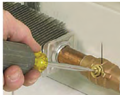
شیر هواگیری کنوکتور
