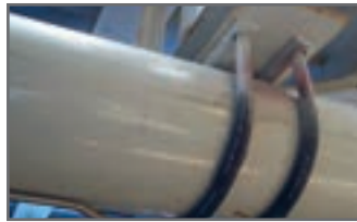
شکل ۱۷- تکیه‌گاه لوله افقی
