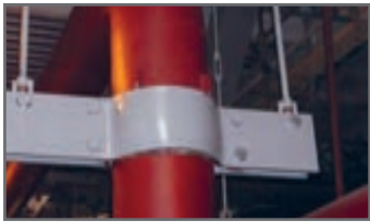
شکل ۱۸- تکیه‌گاه لوله قائم
