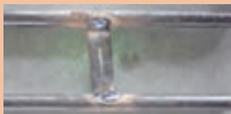
شکل ۱۷- ثابت کردن لوله فلزی
