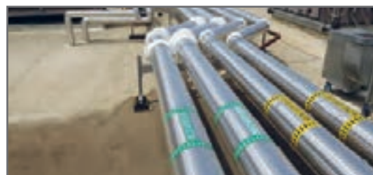
شکل ۳۴- عایق الاستومری با پوشش آلومینیوم
