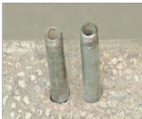
شکل لوله رفت و برگشت در کف
