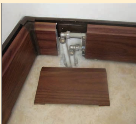
اتصال لوله‌کشی رادیاتور قرنیزی با کاور نهایی
