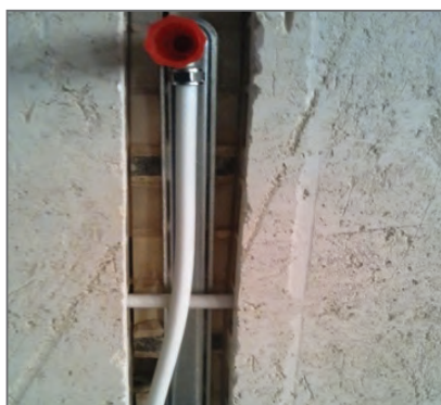
اتصال لوله به دیوار
