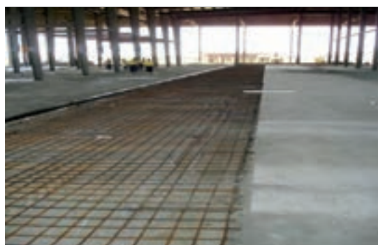
اجرای بتن کف
