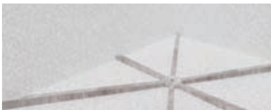
مرحله ۵- در صورتی که فاصله کرم‌ها از یک شمشه بیشتر بود باید کرم‌های بیشتری اجرا شود.
