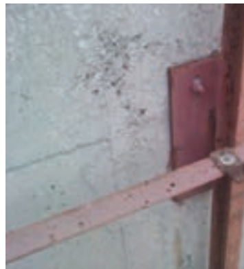
اتصال قطعات زیرسازی سنگ به دیوار
