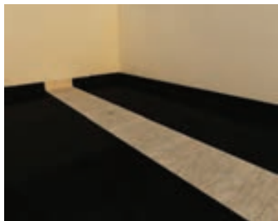
۱- آماده‌سازی کف قبل از اجرای عایق
