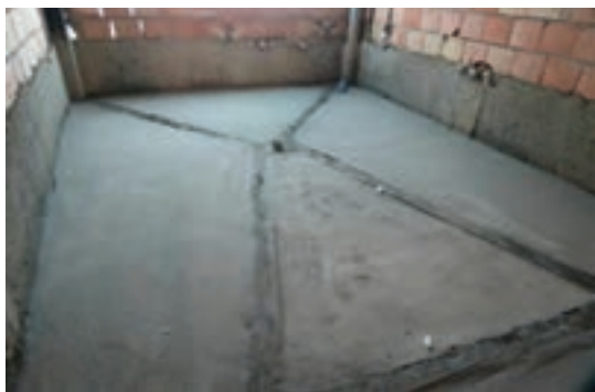
اجرای کرم و بتن شیب‌بندی حمام
