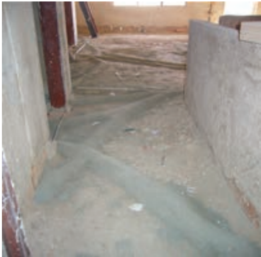
پوشش تأسیسات به منظور محافظت از آنها
