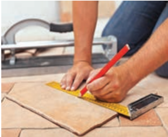
مشخص کردن مسیر برش سرامیک
