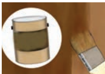
۵- آستر کردن دیوار با آستری (روغن الیف)
