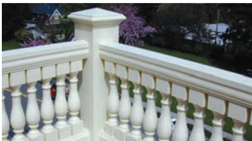
قطعات به شکل صراحی به عنوان دست انداز بالکن
