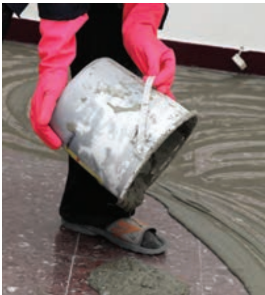
ریختن دوغاب سیمان روی کف و یکدست کردن سطح درزها و کف موزاییک‌ها
