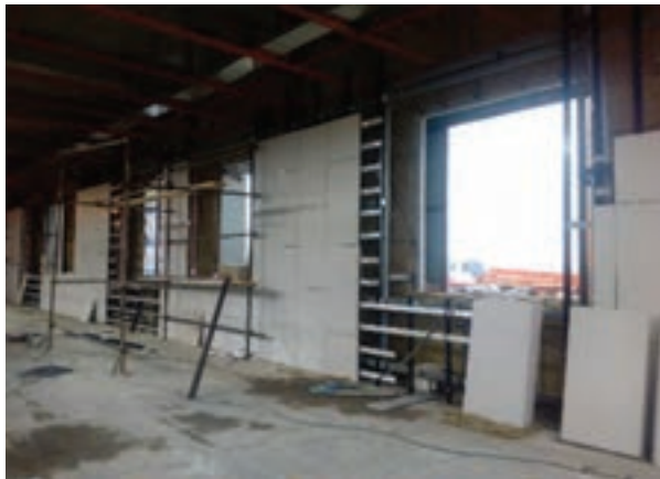
اجرای زیرسازی فلزی
