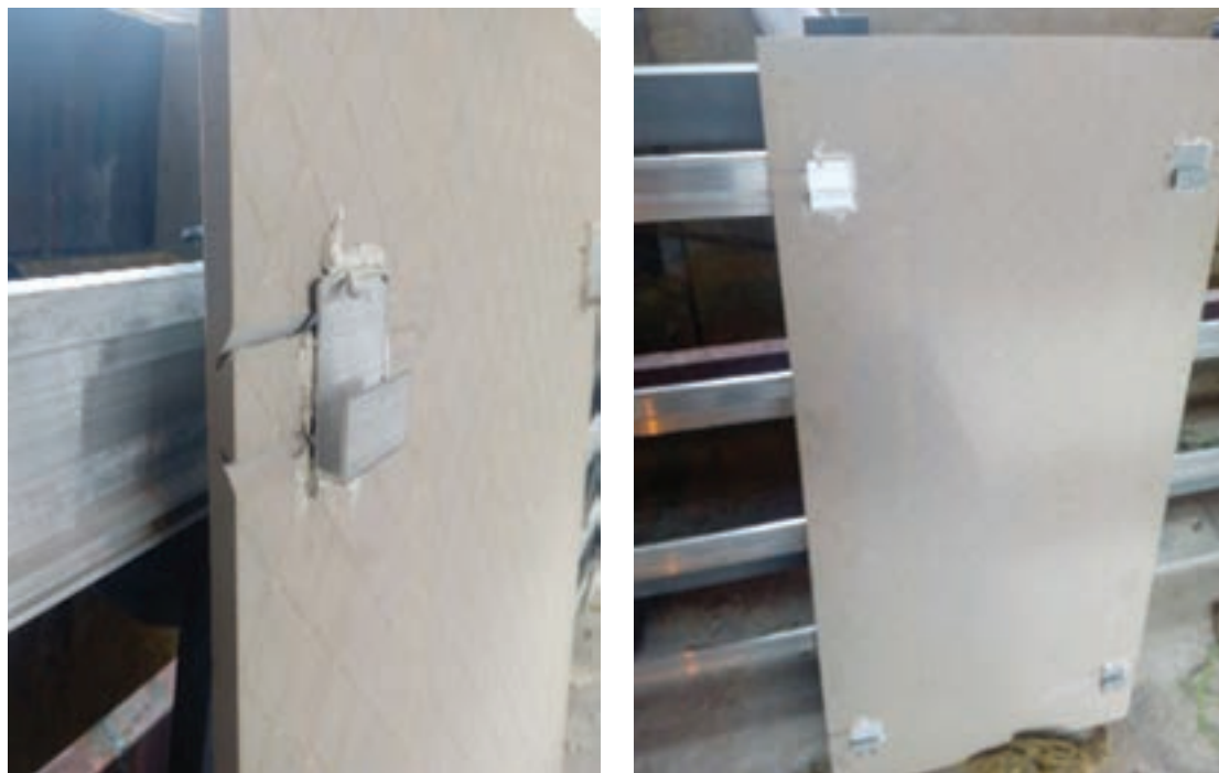
ایجاد شیار برای اتصال قطعه واسطه به پشت کاشی
