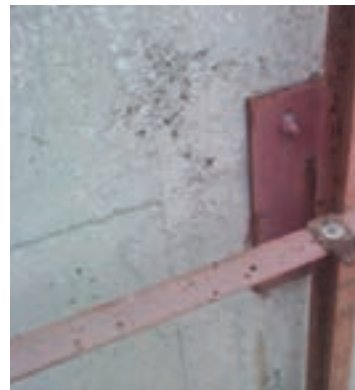
اتصال قطعات زیرسازی سنگ به دیوار
